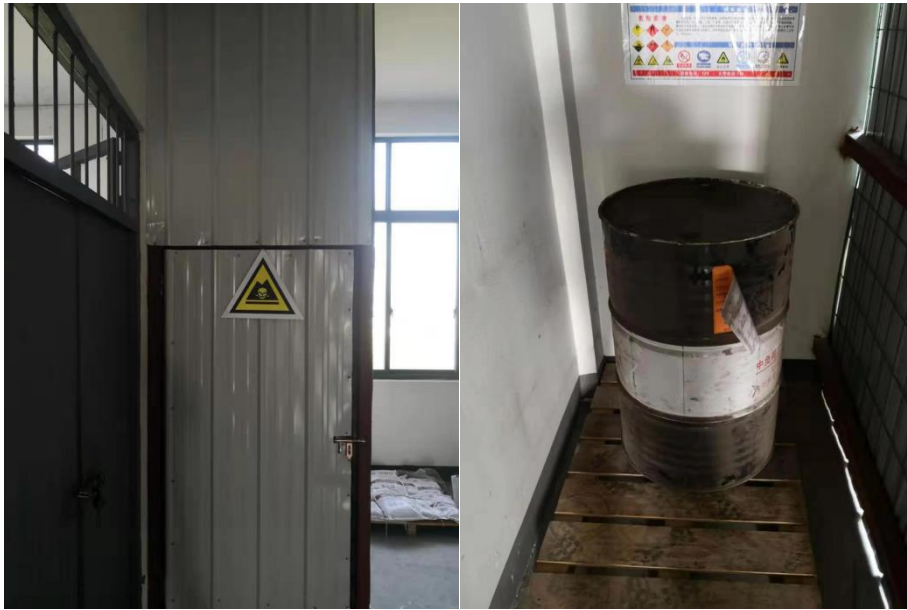
图 4-2 危险废物暂存间现场照片
